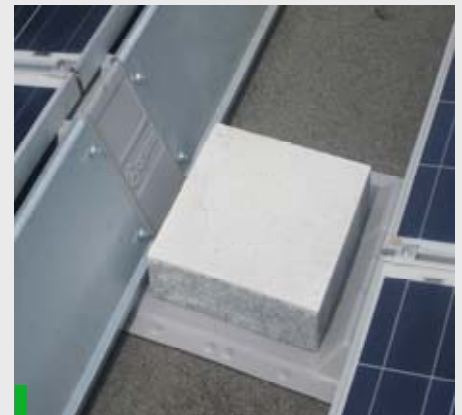
Sujeción mediante Lastre a la Cubierta
