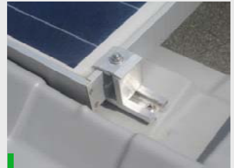
Detalle sujeción lateral de placas
