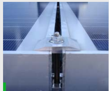
Detalle Fijación Placas
