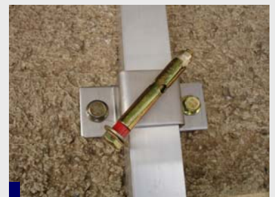
Detalle 3: Sobre hormigón con tacos de expansión.
