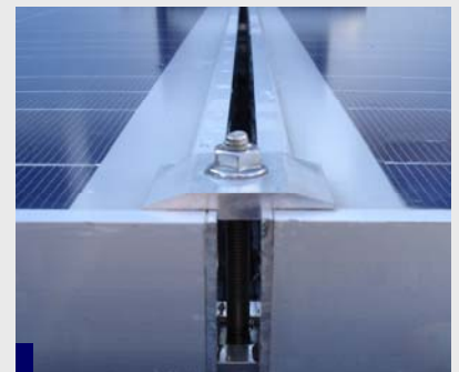
Detalle unión paneles
